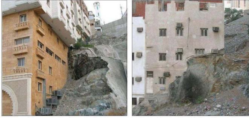
يعتبر اول طابق كامل المساحة فعلياً هو الطابق السادس، حيث هناك خمسة طوابق غير مكتملة بسبب البناء مباشرة على سفوح الجبل بدون قعر، او تهيئة
